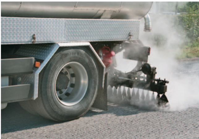
Bitumenemulsion wird angespritzt
