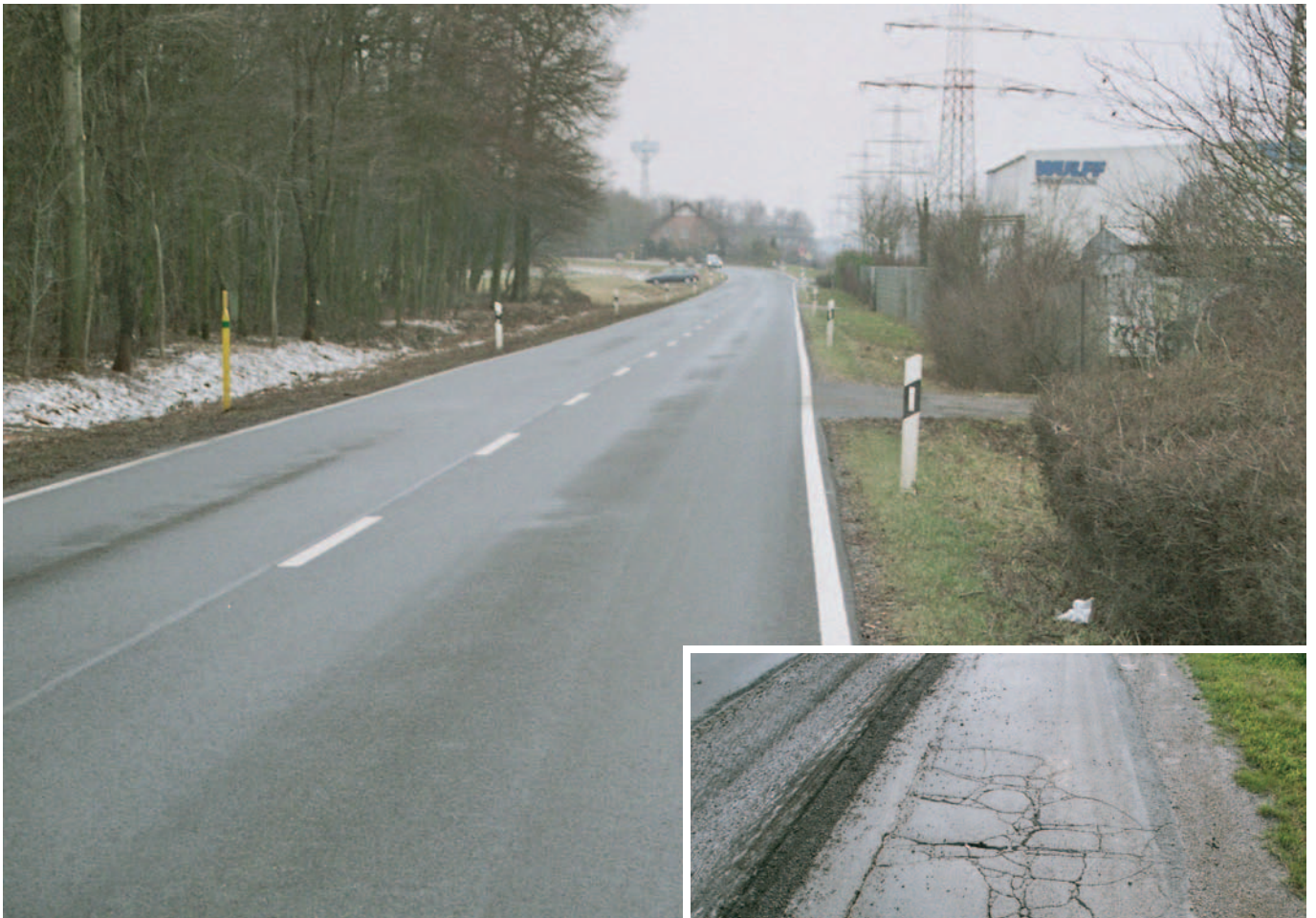
Zustand der neu sanierten K 81/Kreisgebiet Steinfurt
