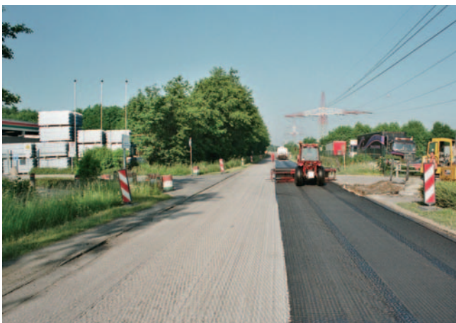
Verlegung des HaTelit® C40/17
