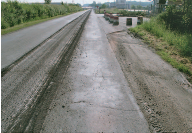
Nach dem Abfräsen der Deck- und Binderschicht
