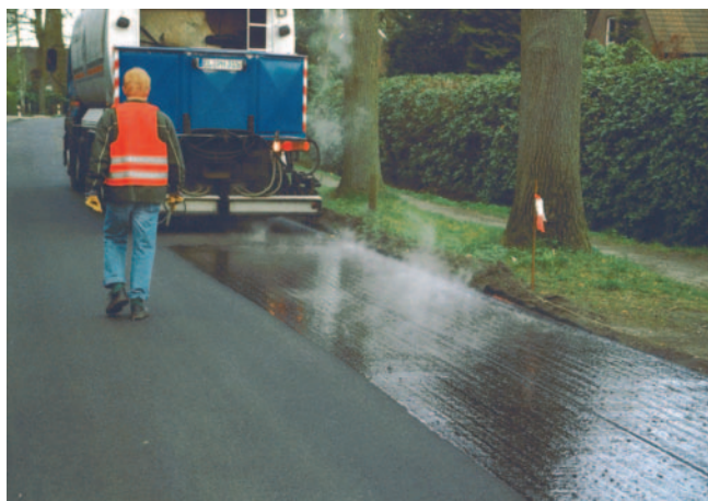
Anspritzen der Emulsion
