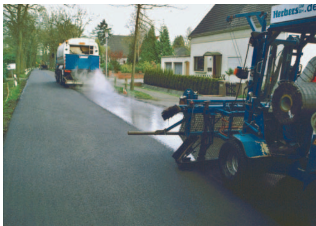
Verlegung des Bewehrungsgitters HaTelit® C40/17
