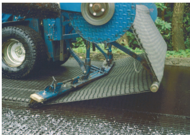
Detailaufnahme des Verlegegerätes
