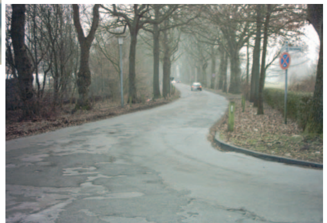
Zustand der Straße vor der Sanierung
