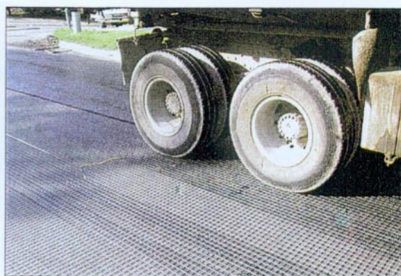
Bild 4: Befahren von HaTelit C 40/17 mit Mischgut-Lkw
