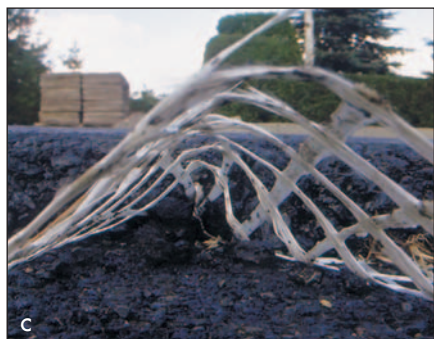
Fot. 1 abc. Kłopoty wykonawców przy układaniu siatek polipropylenowych (a) szklanych (b, c).
